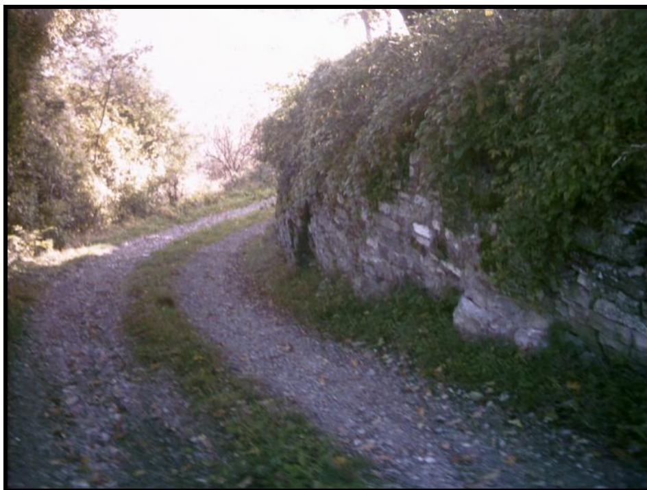
Foto H - Muratura perimetrale - lato Nord
