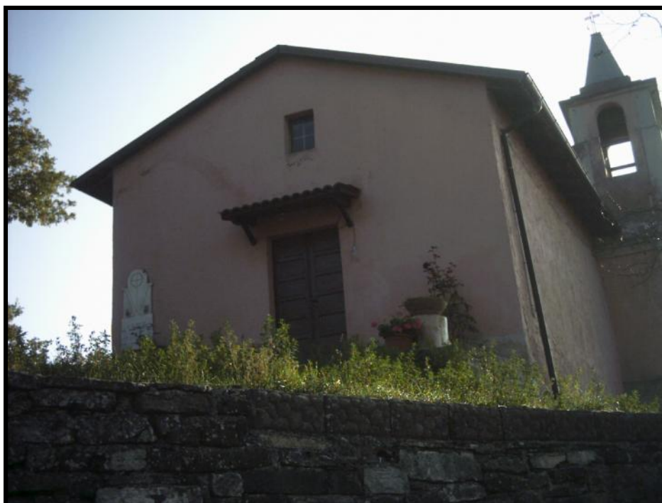
Foto A - Prospetto ovest
