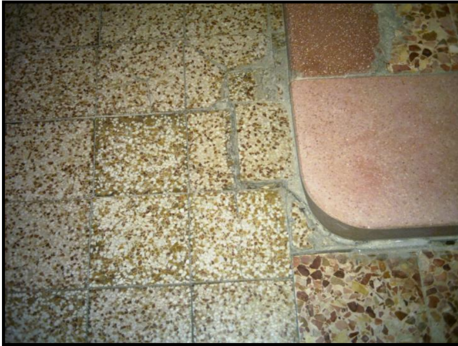
Foto L - Particolare pavimentazione abside-altare
