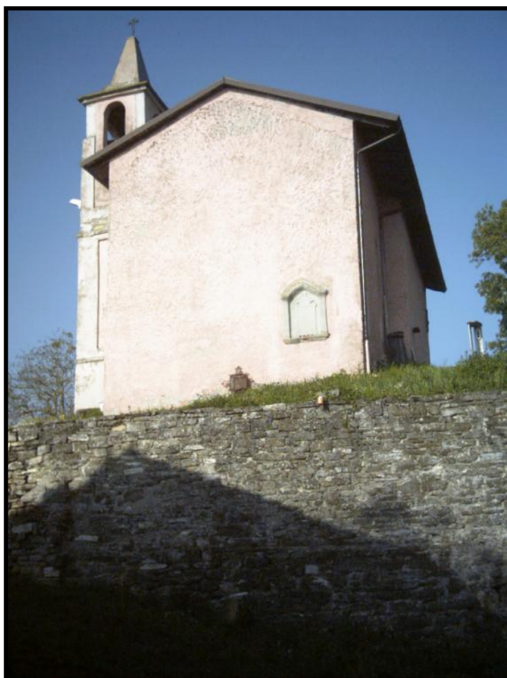
Foto B - Prospetto Est
