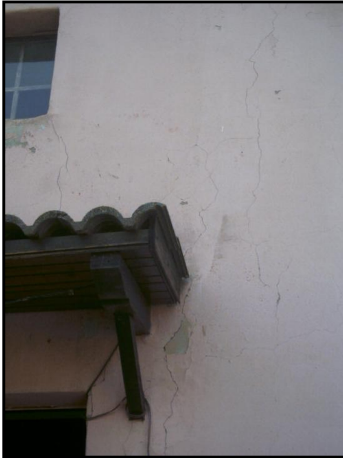
Foto E - Fronte chiesa - lato Est
